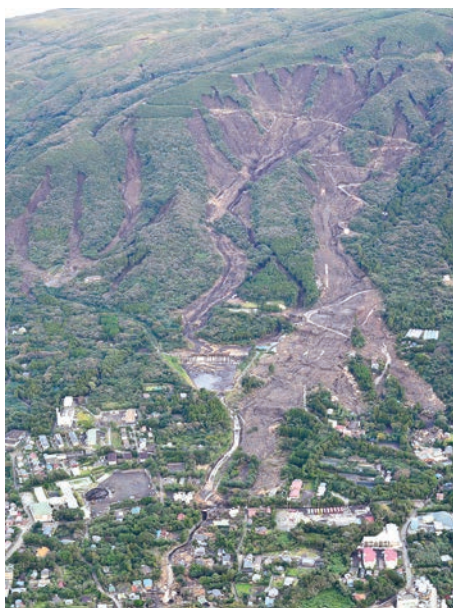
伊豆大島上空からの被害状況
