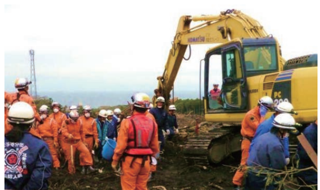
消防団が重機を活用し、緊急消防援助隊を支援 (横浜市消防局提供)
