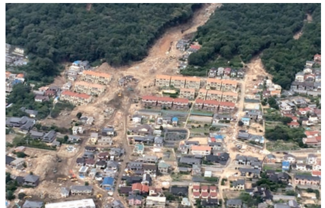
平成26年広島県の土砂災害の被災現場 (広島県広島市)
